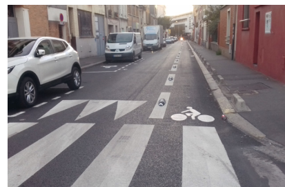
▲ Montreuil, rue Michelet : la protection du contre sens par des modules plastiques est mal vécue par les cyclistes dans le sens général, pressés par des automobilistes qui n'osent plus dépasser. Certains vélos en arrivent à rouler dans la bande à contresens. Moins de trafic, et donc un moindre besoin de protection, serait la réponse adaptée. (Paris en Selle)
