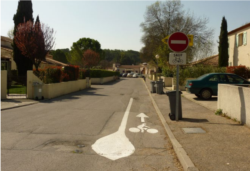
Marquage en début de double sens cyclable, puis rien en section courante pour les rues à faible trafic
