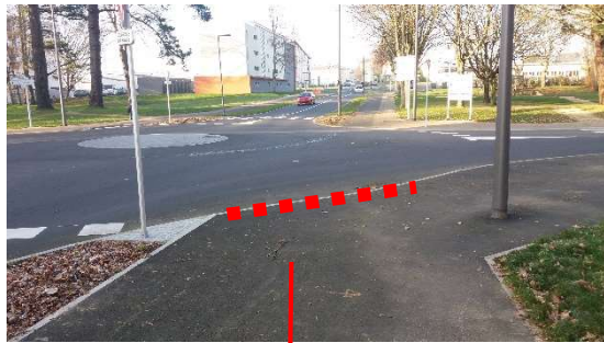
Absence de balise cédez passage Absence pointillé cédez le passage Absence marquage de la piste dans le rond-point
