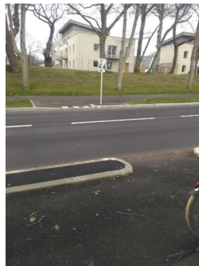
Absence de marquage
