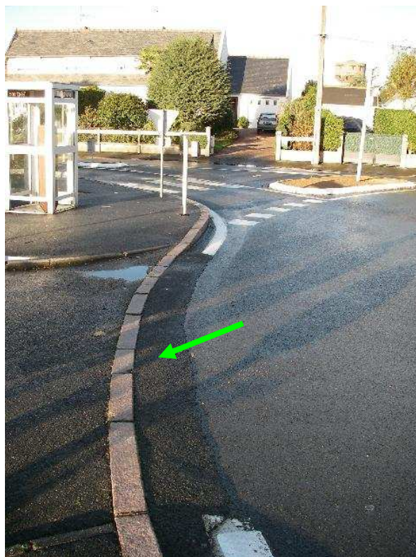
Rampe pour l'accès voiture côté collège.
