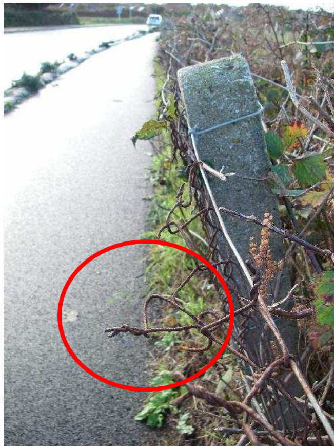
Poteau dépassant sur la piste. Grillage rouillé agressif.
