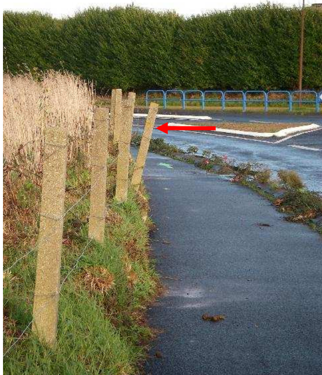
Poteau dépassant sur la piste. Grillage rouillé agressif.
