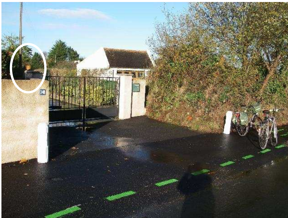
Gyrophare de portail électrique pouvant être décalé pour être plus visible depuis la piste.
